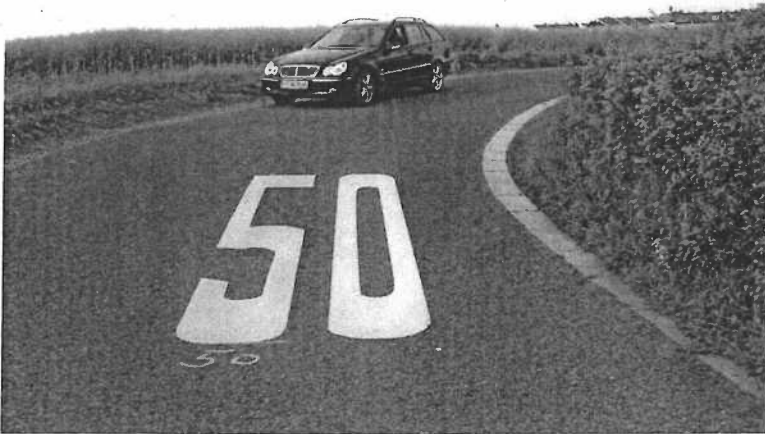
Unübersichtlicher Kurvenbereich Verlängerung Winfriedstraße in Richtung L 91
