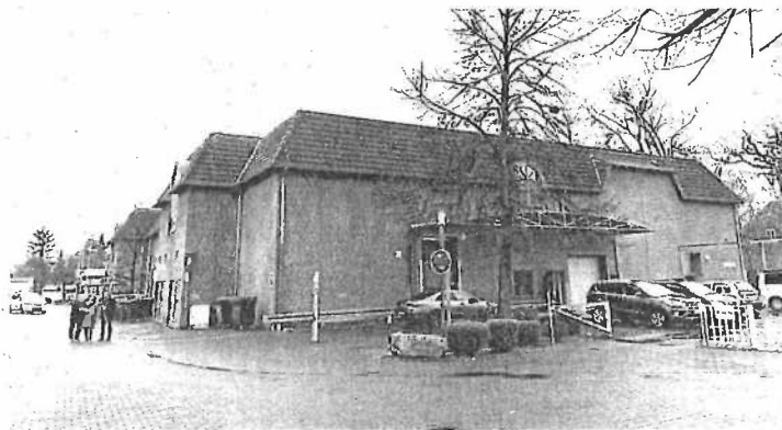
Im ehemaligen Hit- und künftigen Rewe-Gebäude Am Jobberath 2 entsteht ein neues Test- und Impfzentrum.
